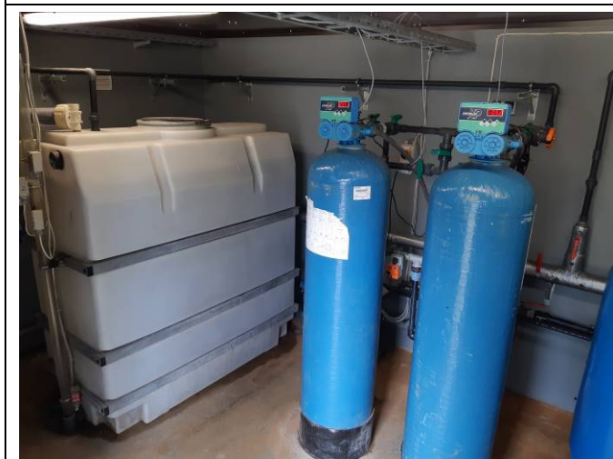
Joonis 13. Vastemõisa keskuse puurkaev-pumpla (katastri nr 5283) ja veetöötlusjaam. Fotod: OÜ Alkranel 29.04.2020.
