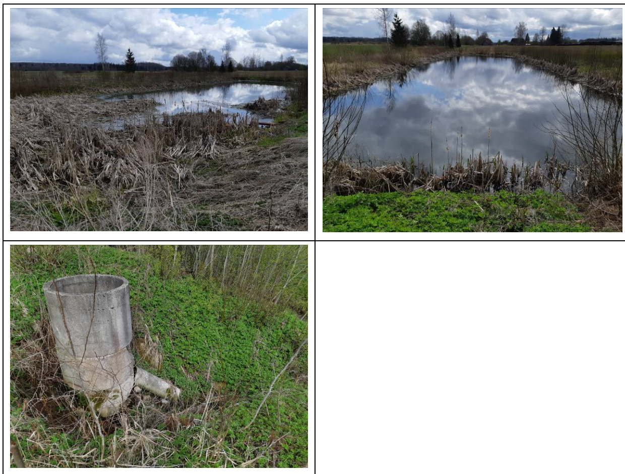
Joonis 12. Kõpu aleviku reoveepuhasti. Fotod: OÜ Alkranel 29.04.2020.
