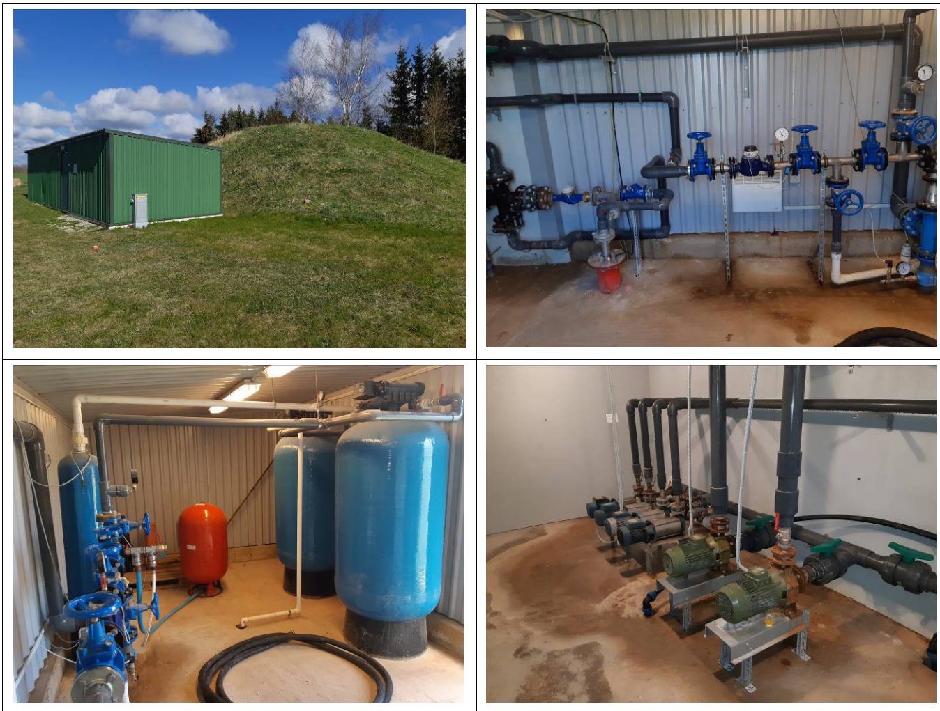
Joonis 6. Võhma linna Pargi tn uus puurkaev (katastri nr 23940) ning veetöötusjaam. Fotod: OÜ Alkranel 30.04.2020.
