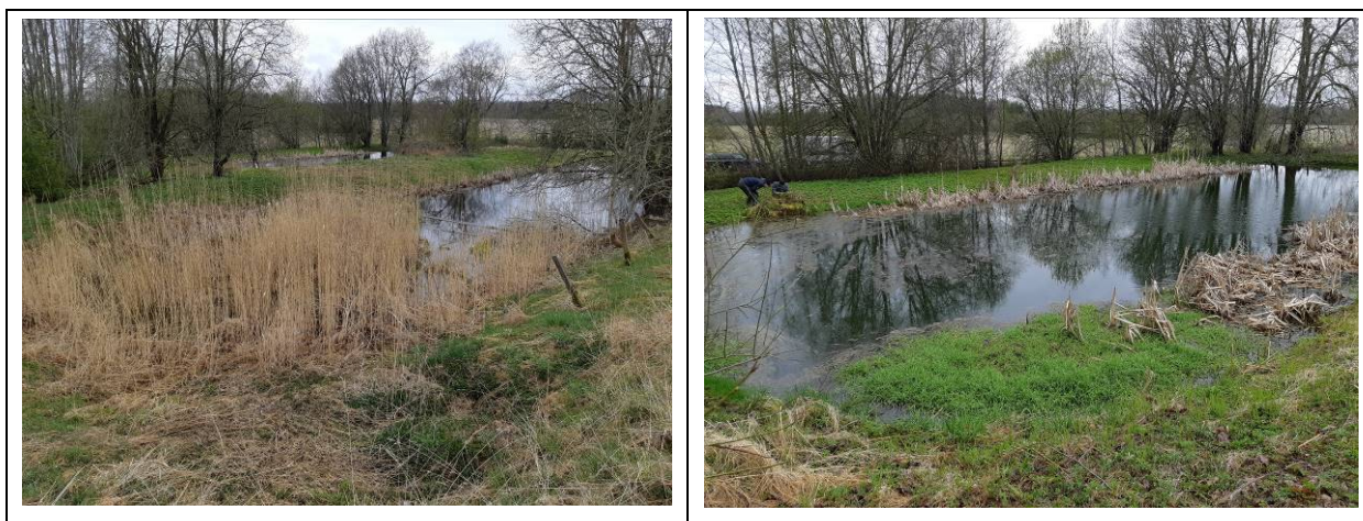
Joonis 31. Navesti küla reoveepuhasti (biotiigid). Fotod: OÜ Alkranel 29.04.2020.
