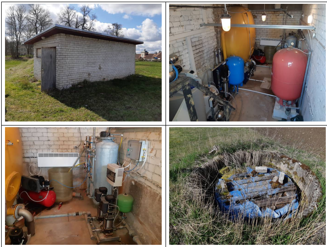
Joonis 18. Kõo küla puurkaev-pumpla (katastri nr 6057) ja veetöötlusjaam. Fotod: OÜ Alkranel 30.04.2020.
