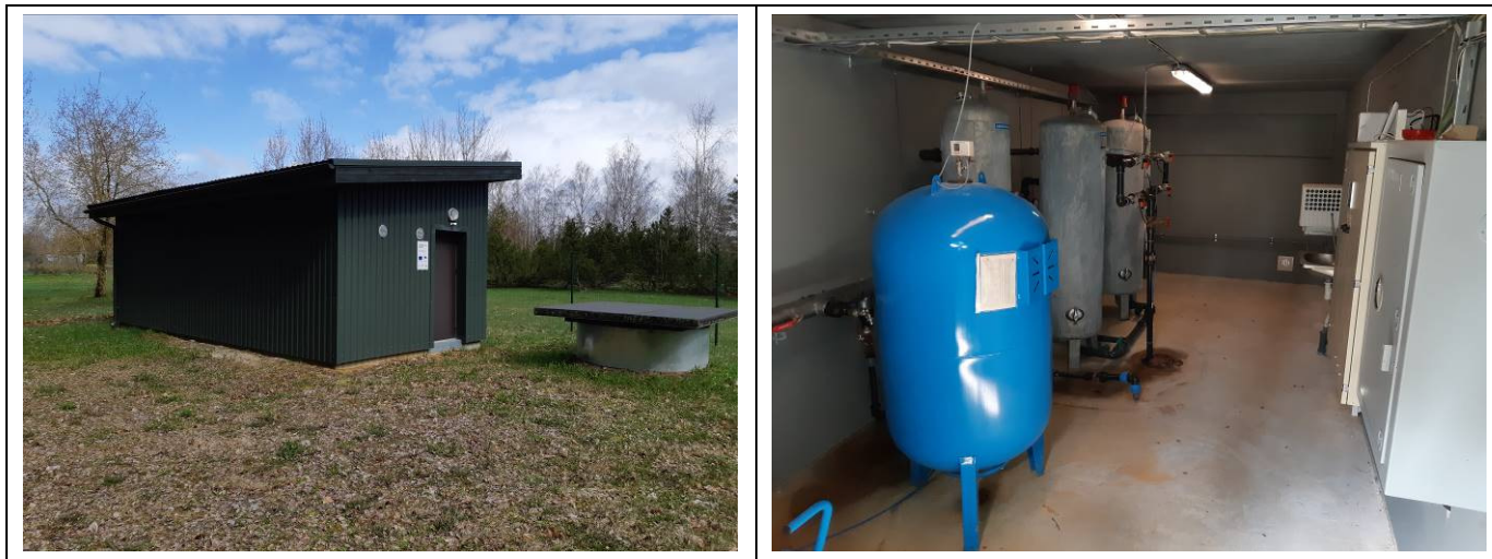
Joonis 22. Reegoldi küla puurkaev-pumpla ja veetötlusjaam. Fotod: OÜ Alkranel 29.04.2020.
